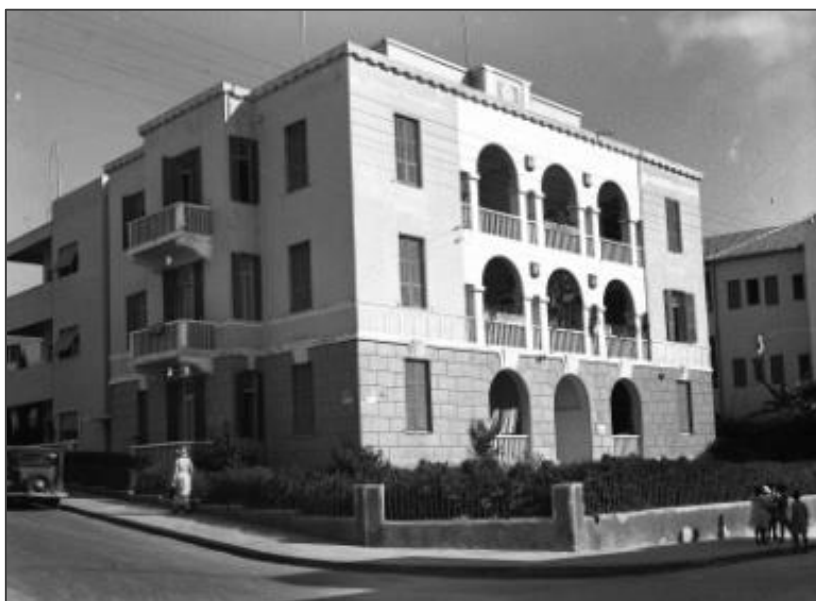
תמונה מס' 25 – פינסקר 10, במבנה זה ניתן להבחין כי הקירות הראשיים צבועים בגוון מעט כהה מגוון הקיר הנסוג באזור הקשתות. לקומת הקרקע גוון קיר יותר כהה ובעל מרקם טיח בעיצוב
