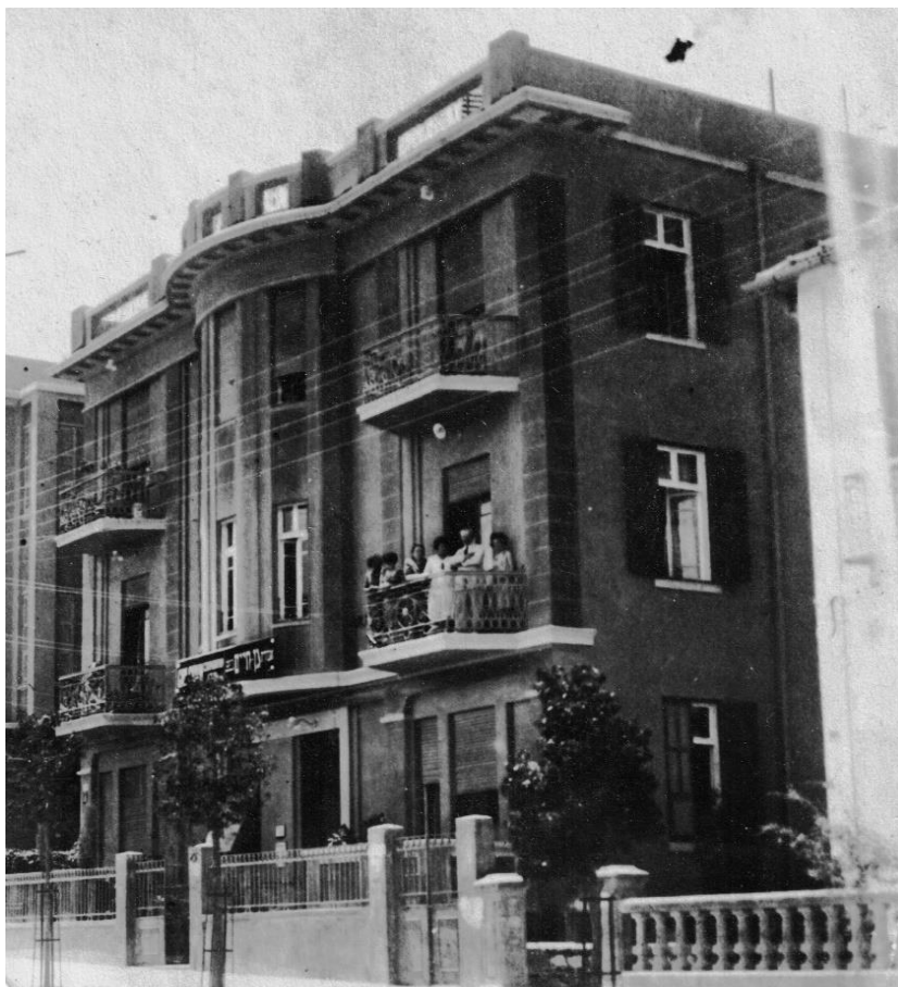
תמונה מס' 24 – בית נתן מץ ברחוב אלנבי 122. קרניזים, גגונים ומרפסות צבועים בגוון בהיר, הקירות בגוון יותר כהה. בנוסף, קיימת הדגשה של פינות האלמנט המרובע בחזית על ידי גוון יותר כהה וטיח במרקם של אבנים. (מתוך אוסף אילנה מץ)
