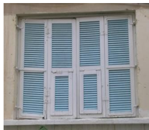
שנות ה-20-30 תריסי עץ מתקפלים לפתיחה, הסדרת חלקים נפרדים לפתיחה לוקלית לצורך אוורור
