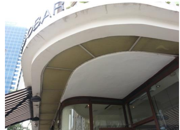
הצללת כניסה לבית קפה על ידי קירוי בגגון בטון עם שילוב תאורה הרצל 8 פ. שדי רוטשילד 8
