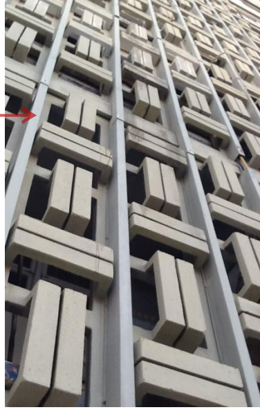
מסטור למערכות טכניות ולחללי שירות על ידי אלמנט דקורטיבי מפריקסטי בטון
