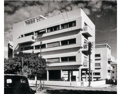
הסדרת חלונות בבליטה ממישור החזית מעניק הגנה מפני חדירה ישירה של קרני השמש
