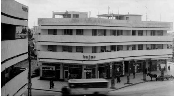
מערכת של מרפסות היקפיות - מעקה בנוי וסינר עליון יוצרים קיר קליפה מעניקה הגנה מפני קרני השמש. החריץ הדק שמנתק את מעקה מסינר נועד לשחרר אוויר חם שמתרכז בחלקה העליון של המרפסת
