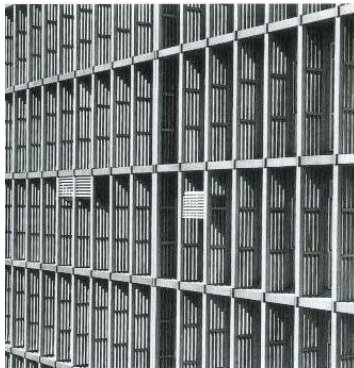
הסדרת הגנה מחדירת קרני השמש על ידי מסך של מערכת פריקסטי בטון של שוברי שמש מרושטים ("בריסוליים")
