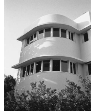
הסדרת גגון מעל הפתחים מעניק הגנה מפני חדירה ישירה של קרני השמש
