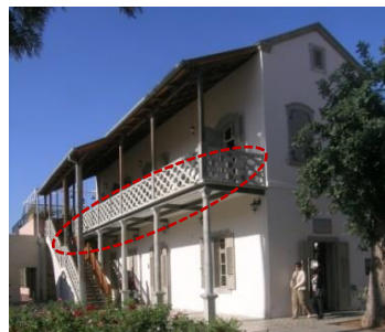
בניה טמפלרית - משרביה מפריקסטי בטון (תמונה בצד ימין), מצינורות חרס (תמונה מצד שמאל) במעקה גג, במעקה מרפסת ובגדרות
