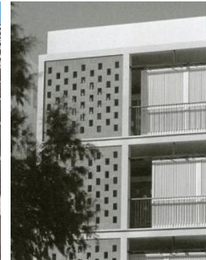
הסדרת הגנה מחדירת ישירה של קרני השמש על ידי משרביה מבלוקי בטון
