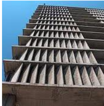
הסדרת הגנה מחדירת ישירה של קרני השמש על ידי לוחות בטון/אסבסט אנכיים
