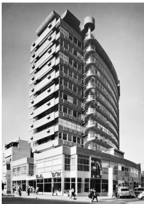
1962 | בית אל על, דב כרמי, רם כרמי, צבי מלצר מוטיב המצחייה על גג המבנה מופיע בשתי החזיתות הפונות לרחובות, מדגיש פינת הרחובות ומסתיר את מערכות הטכניות על גג המבנה.
